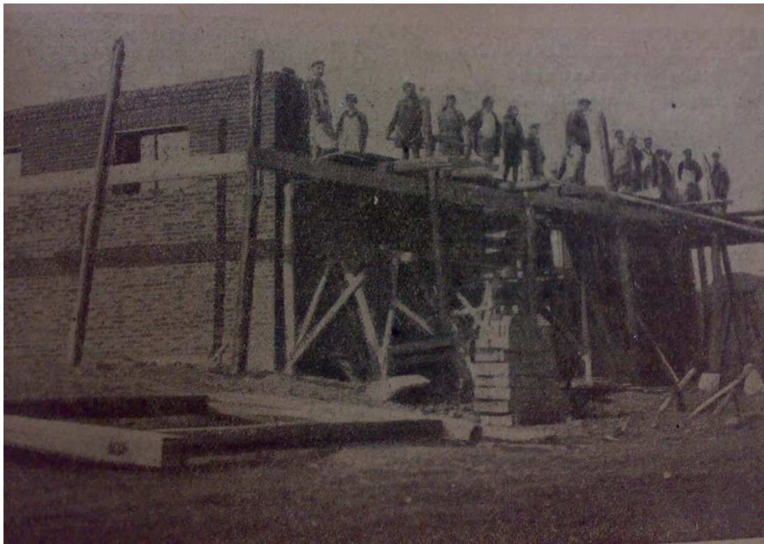
Рис. 2. Будівництво маточної стайні Стрілецького кінного заводу (1931 р.)
